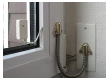
Figura14: Detector de trencament de vidres
