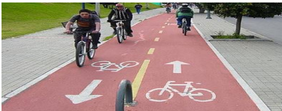
Imatge 22: Carril bici pavimentat de formigó porós
