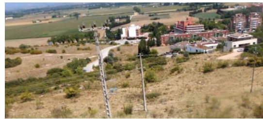
Imatge 25: Torres de les línies elèctriques.
