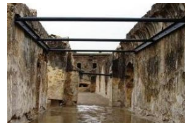
Imatge 12. Interior de l'Hospital.
