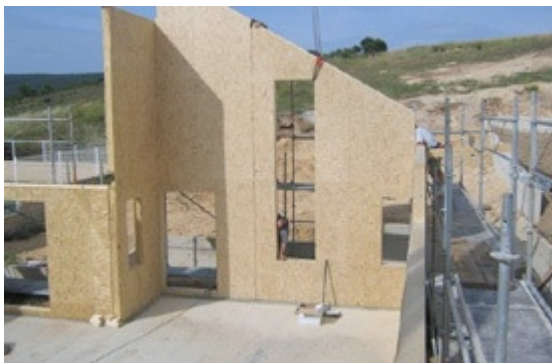
Imatge 6: Estructura de plaques de fusta laminada
