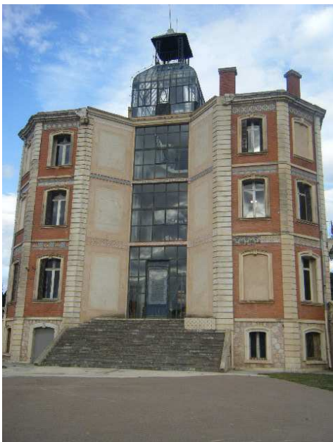
11. Estat actual de conservació de la Maternitat d'Elna
