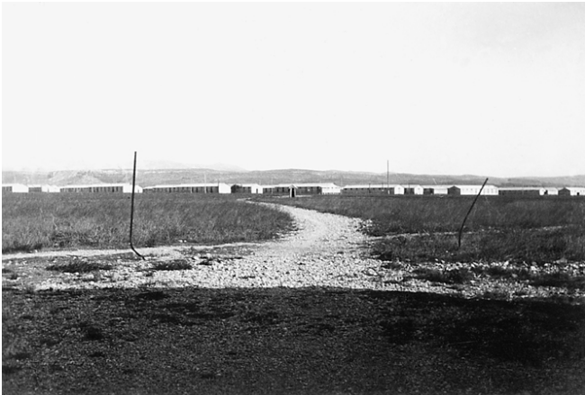
39. Vista general del camp
