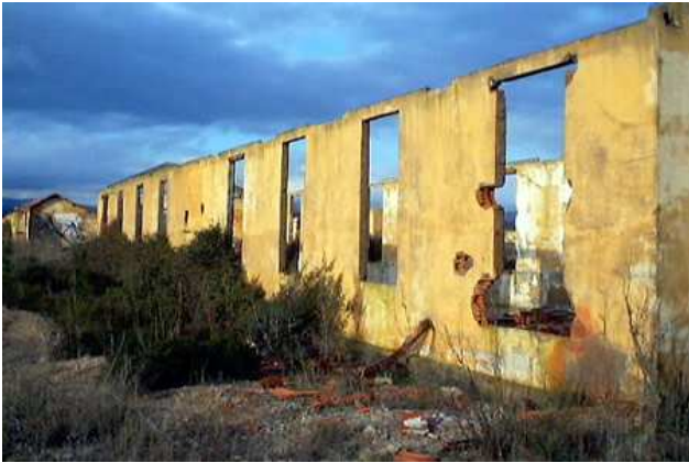
59. Les parets cauen a trossos de les antigues barraques
