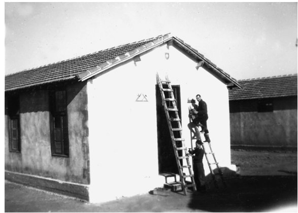
36. Manteniment del camp. Uns homes pintant una paret
