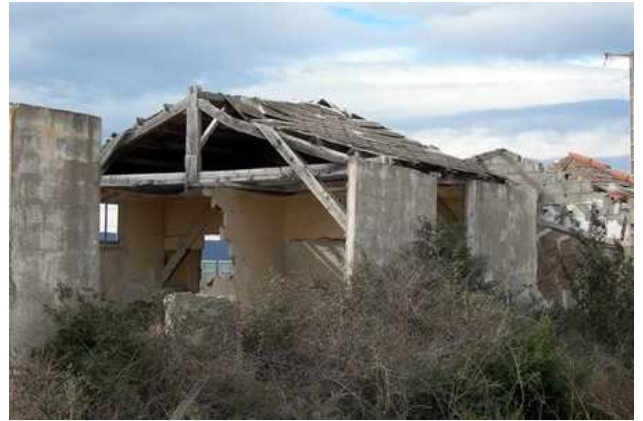
60. Els sostres s'esfondren amb el pas del temps, són castigats pel fort vent que bufa al camp
