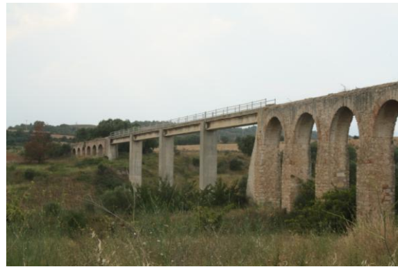
Plataforma que enllaça les dues parts de l'aqüeducte. Font: propia
