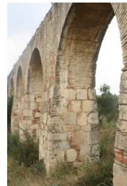
Arc on s'aprecia la maçoneria. Font: propia.
